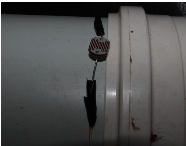
Figura 46: Sensor de iluminação no último andar da estrutura
